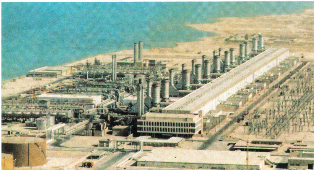
شکل ۱۷۰- تاسیسات ترکیبی نیروگاه گازی و آب شیرین کن در دوحه قطر
